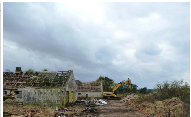
BEISPIEL 9: RÜCKBAU SCHWEINEMASTANLAGE FRANKENFELDE UND RENATURIERUNG DER FLÄCHEN
